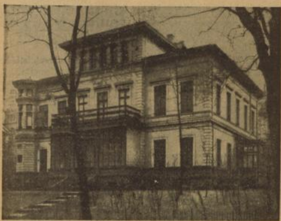
Die Villa Reiß in E 7 Ansicht von der Gartenseite
