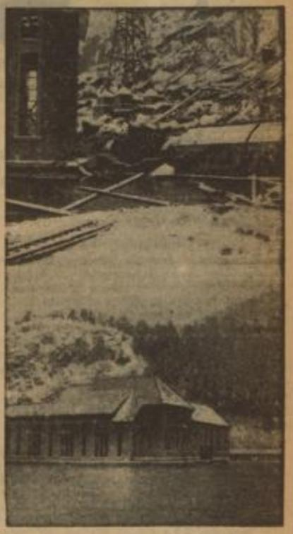
Die erst kürzlich eröffnete Talsperrung von Rembs am Oberrhein war Schauplatz einer Katastrophe, die 9 Menschenleben forderte. Oben: Die Bruchstelle des großen Zuleitungsrohres; unten: Durch den Bruch des Zuleitungsrohres wurde das Kraftwerk in einer Höhe von ungefähr 10 Metern vollständig von Wasser umgeben.
