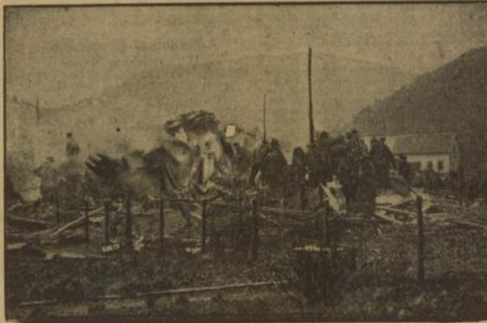
Die Trümmerstätte von Plettenberg im Sauerland, wo eine schwere Gasexplosion in Wohnhaus vollkommen vernichtete und fünf Todesopfer forderte. Das Unglück ist wahrscheinlich auf eine schadhafte Stelle in der dort vorüberführenden Ferngasleitung zurückzuführen.
