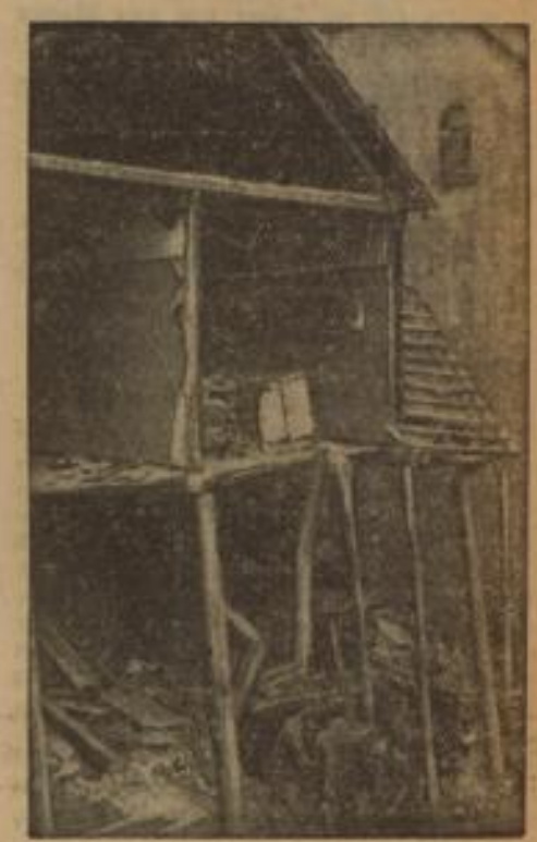
In einem einstöckigen Wohnhaus in der Gartenstraße 14 in Hannover ereignete sich eine schwere Gasexplosion, durch die das Gebäude vollständig zerstört wurde. Unter den Trümmern wurden vier Brauen begraben. Sie konnten inzwischen geborgen werden und sind schwerverletzt dem Krankenhaus zugeführt worden. Außerdem zogen sich sechs Beamte der Feuerweh und zwei Arbeiter der Gaswerke Verletzungen zu.
