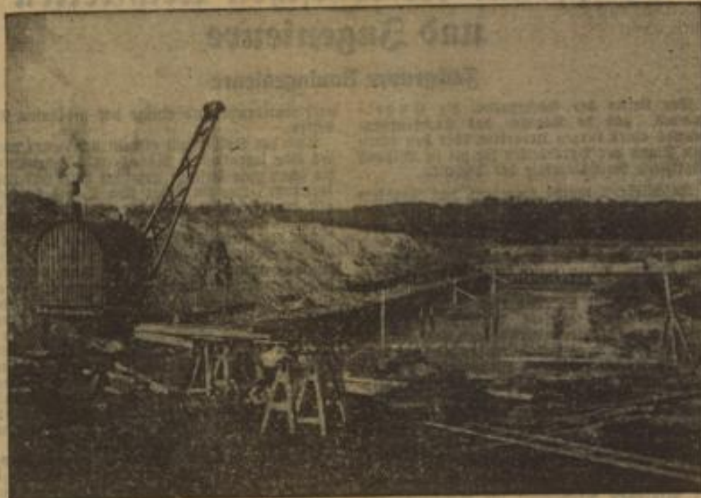
In Magdeburg wird gegenwärtig vom Freiwilligen Arbeitsdienst eine gewaltige Schwimmbahn erbaut, die bereits im August 1934 mit den Kämpfen um die Europa-Schwimmermeisterschaften eingeweiht werden soll.
