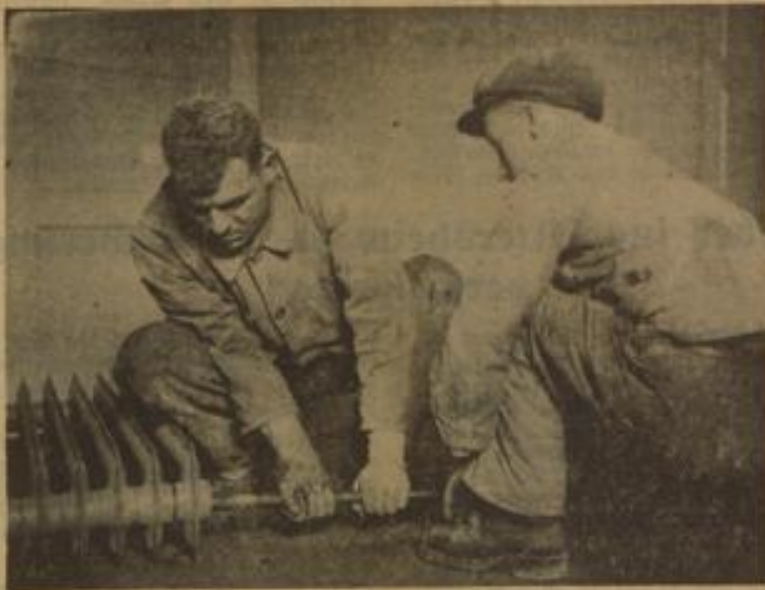
Einbau einer Zentralheizung
