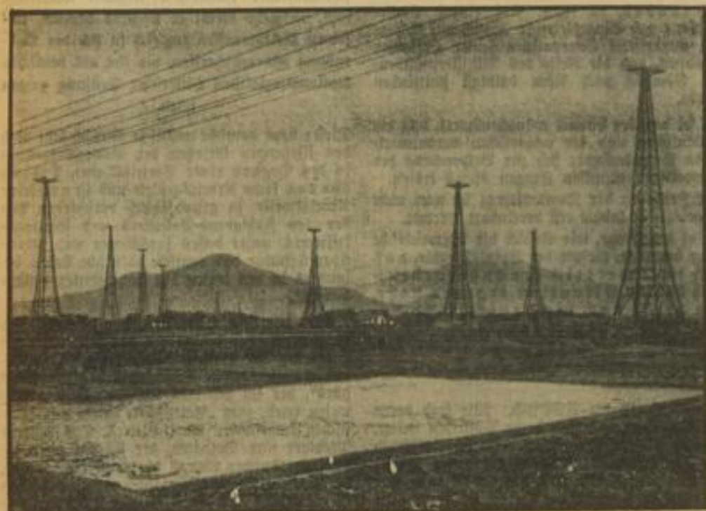
Die gewaltigen Antennenmasten der vor der Vollendung stehenden Funkstation in Bandung auf Java, von der aus eine radiotelephonische Verbindung nach USA geschaffen werden wird. Nach ihrer Vollendung wird es insolge des bestehenden Zeitunterschieds möglich sein, daß jemand am Sonntagmorgen vom Frühstündchen in Java aus seinen Freund anruft, der in San Francisco am Samstag beim Nachmittagskaffee sitzt.
