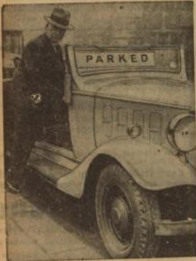
Ein Londoner Kriminalkommissar hat diese neue Schutzvorrichtung gegen Autodiebstahl ausprobiert. An der Windschutzscheibe vor dem Fahrer ist ein hölzerner Kasten heruntergelassen, der nach außen die Aufschrift „Parked“ trägt und einem Autodiebstahl die Sicht unmöglich macht. Dieser Kasten ist verriegelbar und kann nur vom Eigentümer des Wagens wieder entfernt werden.
