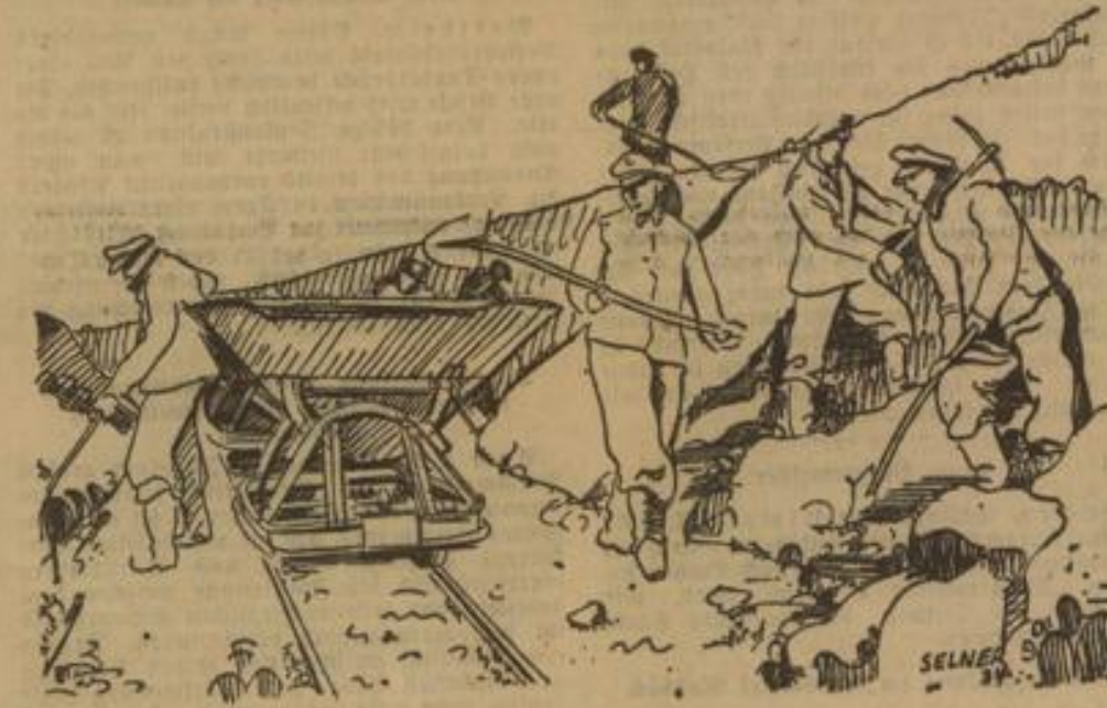
HB-Klischeo Der alte Damm wird abgetragen
