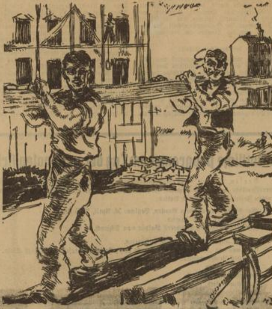
An der Baustelle
