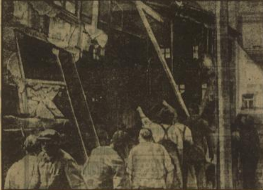
In Winterbach unweit von Stuttgart stürzte während des Unterrichts das Schulgebäude des Ortes ein und begrub den Hauptlehrer Rohde und 7 Schulkinder unter seinen Trümmern. Unser Bild zeigt die Unglücksstelle kurz nach dem Einsturz.
