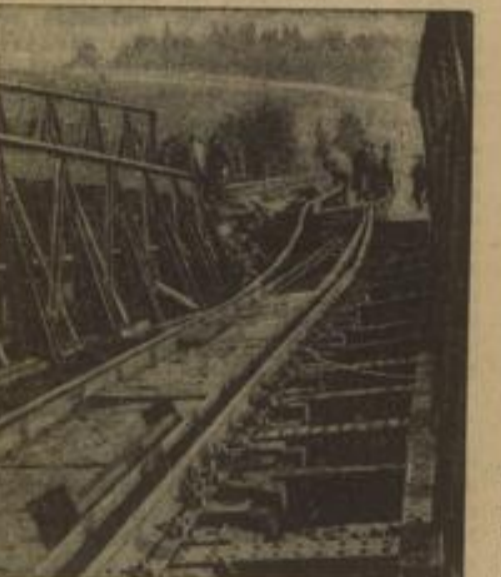
Die gesprengte Eisenbahnbrücke in der Nähe von Redi-Bühl, auf die ein schweres Attentat verübt wurde. Die Eisenbahnschienen wurden durch einen Bombenschlag aufgerissen, so daß der Zugverkehr nach Salzburg und dem Westen unterbrochen wurde.
