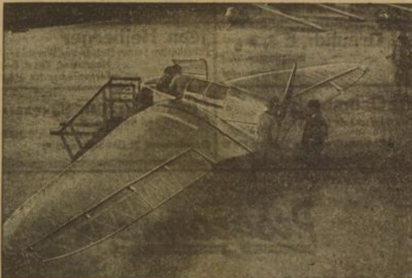
die soeben für den Ozeanflieger Hauptmann Köhl in den Flugzeugbauwerkstätten der Ingenieurschule Weimar gebaut wurde. Sie ist ein Zweiflügler, weist eine Spannweite von 13 Meter auf und verfügt über ein einziehbares Fahrgerüst und einen Hirth-60-PS-Hoch-Motor. Die Einflugversuche begegnen allenthalben größtem Interesse.
