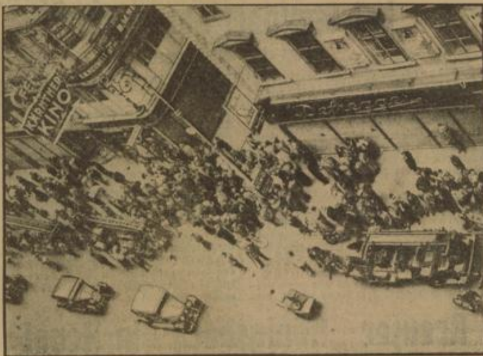
Blick auf die Menschenmenge vor dem Gebäude der Wiener Mundfunkgesellschaft (Raxhaus). Das Raxhaus hat durch den Kampf, der am 25. Juli um das Gebäude tobte, sehr stark gelitten.
