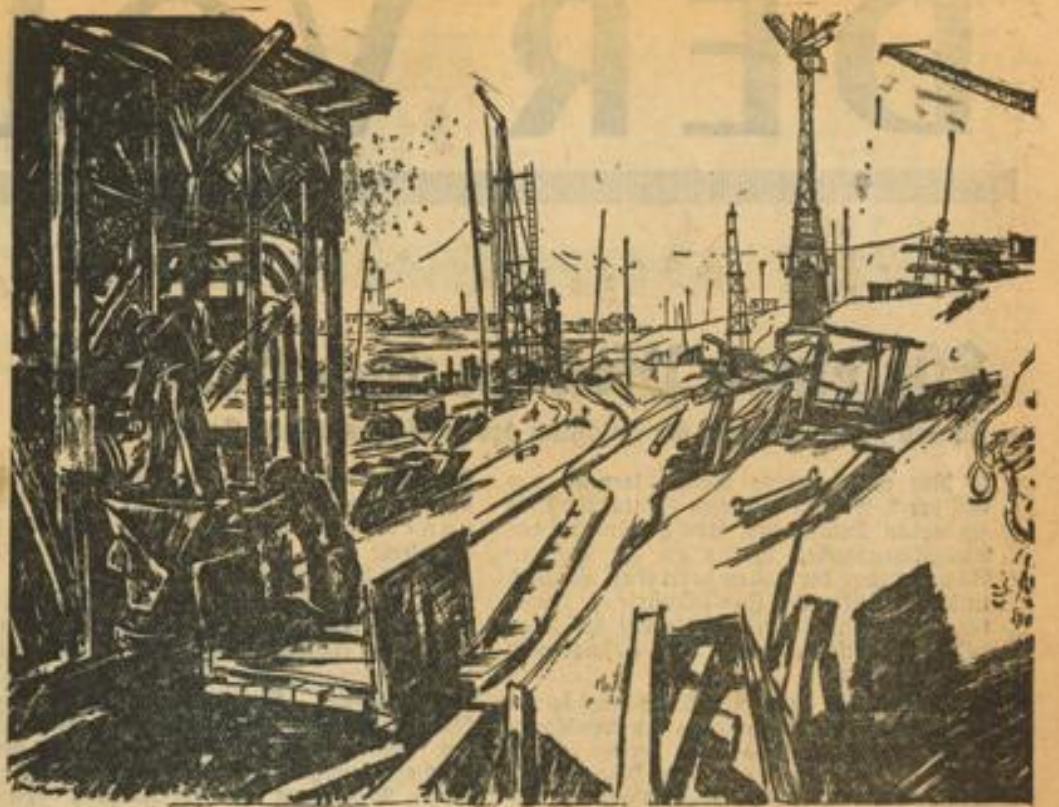
Die Betonmischmaschinen, links, an der Baustelle bei Feudenheim
