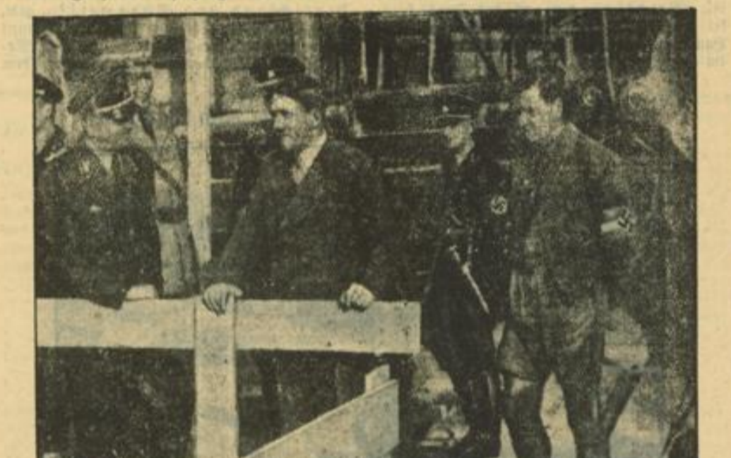
Der Führer überzeugte sich kürzlich persönlich von dem Fortschritt der Arbeiten zum Neubau des Braunen Hauses. Neben ihm rechts der Reichsjugendführer Baldur von Schirach
