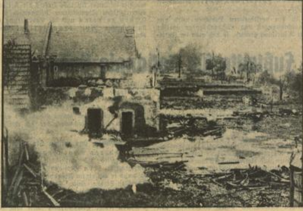
In Friesheim bei Regensburg sind durch Brandstiftung 28 Gebäude vollkommen eingäschert worden. Eine Häuserfront von 280 Meter Länge stand in Flammen. Viele Einwohner des Ortes haben Haus und Hof verloren.
