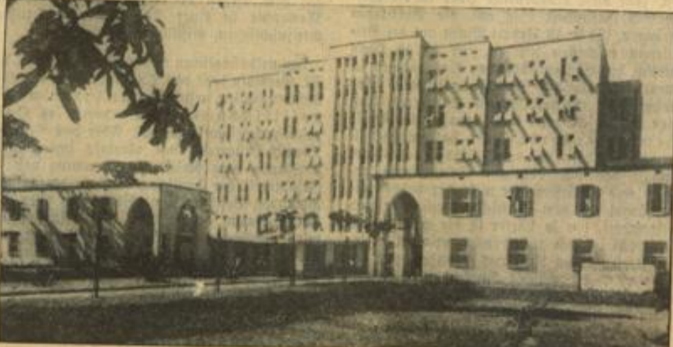
Die deutsche Kolonie in Rio de Janeiro hat in der brasilianischen Hauptstadt ein mit allen Neuerungen ausgestattetes Krankenhaus errichtet, das als modernstes Hospital Rio angelesen wird. Unser Bild zeigt die Vorderansicht des neuen Krankenhauses.
