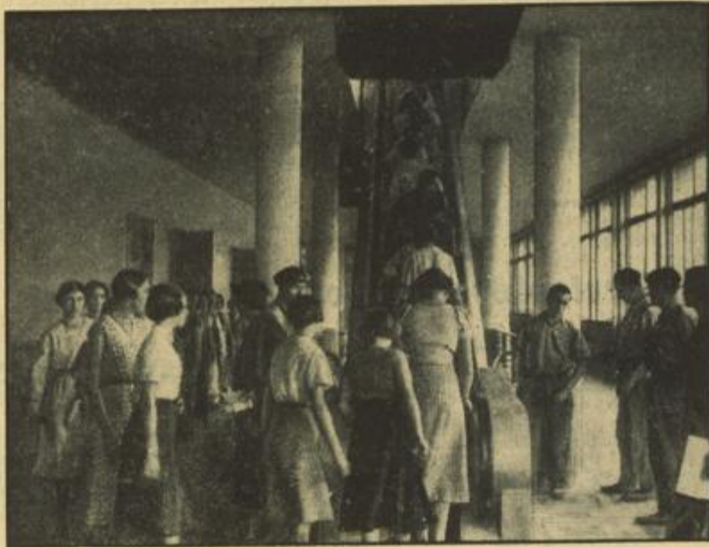
Eine Pariser Schule wurde nach gründlichem Umbau mit einer Rolltreppe ausgestattet, die bei der Jugend begeisterten Anklang fand.
