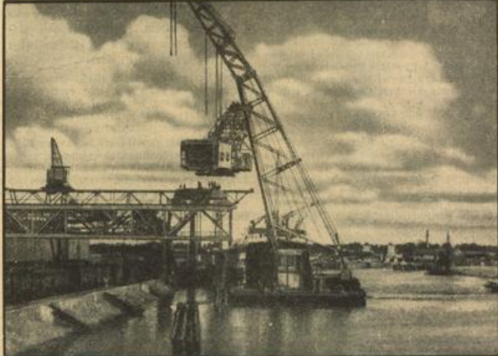
Im Bremer Industriehafen wurde diese neue Verladebrücke für den Kohlenumschlag in Betrieb genommen, die mit 40 bis 50 Tonnen Hub wohl das modernste und größte Transporthilfsmittel ist. Auf unserem Bild sieht man das Aufsetzen des 93 Tonnen schweren Drehlaufkrans auf die Verladebrücke mit Hilfe eines Schwimmkranes.
