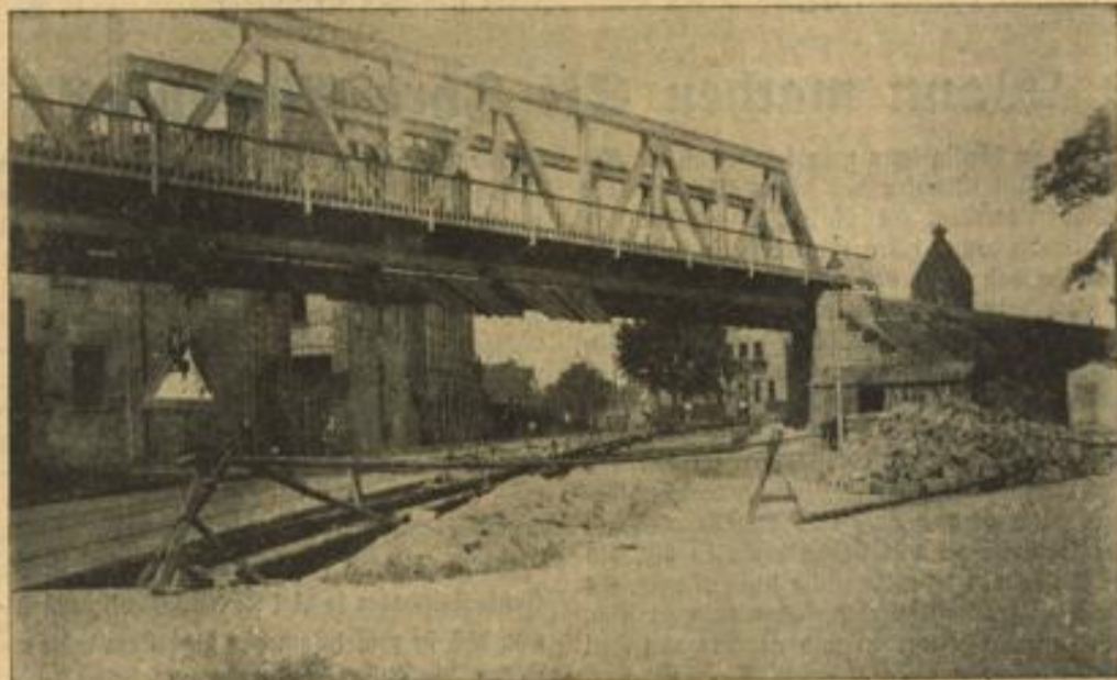
Die Baustelle an der Luzenberg-Auffahrt
