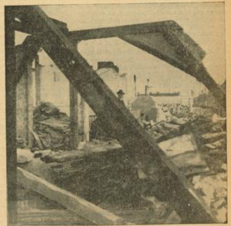
„Triumphbogen des Aufbaues“ Dachgebälk steht frei und wartet auf Abbruch
