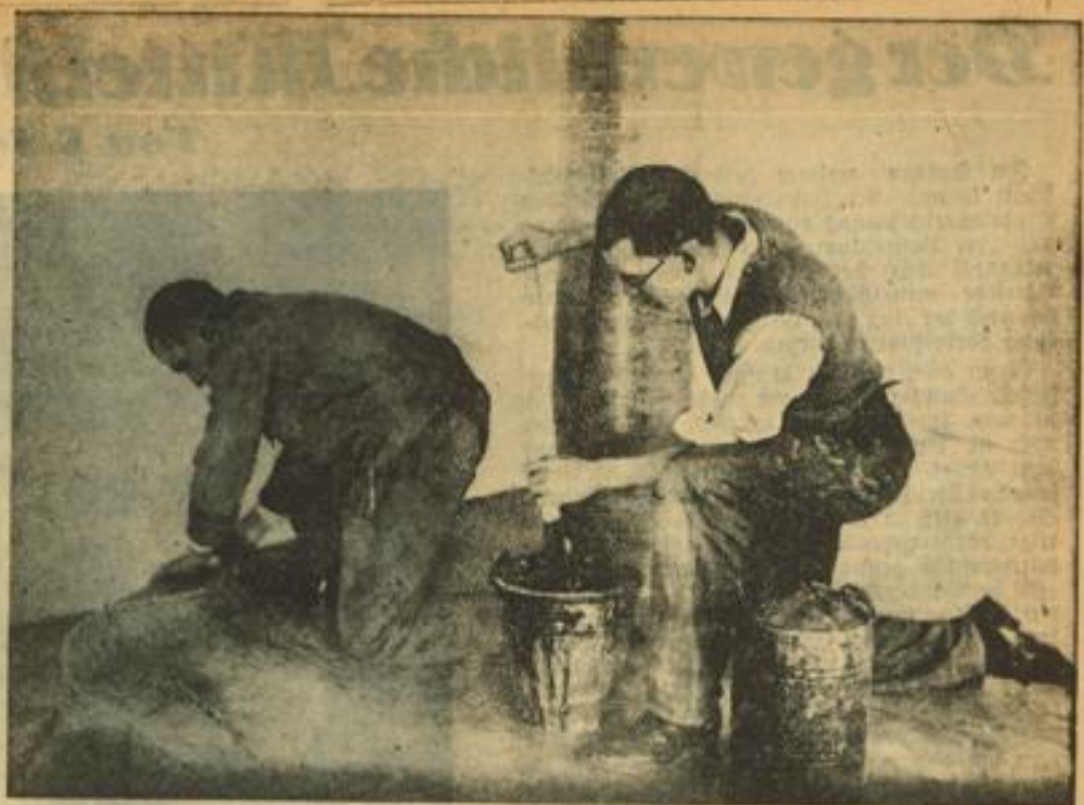
Linoleum wird gelegt
