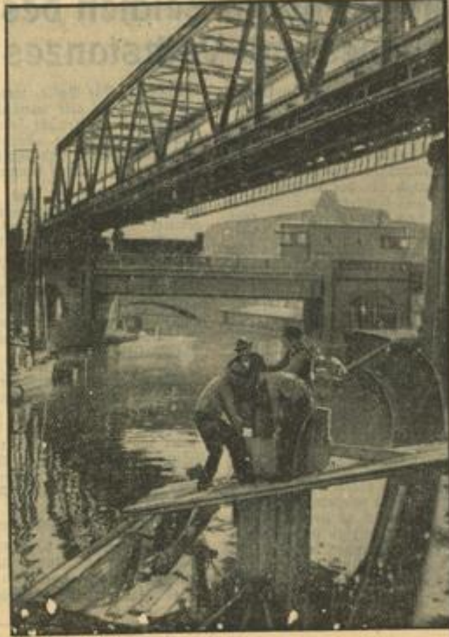
In diesen Tagen wird ein neues Tunnelstück der Berliner Nord-Süd-Bahn in Angriff genommen: Die Untertunnelung des Landwehrkanals im Zuge der Trebbiner Straße. Riesige Dampfhammer rammen hier zunächst vier eiserne Spundwände ein, um das Wasser von der Baustelle fernzuhalten.
