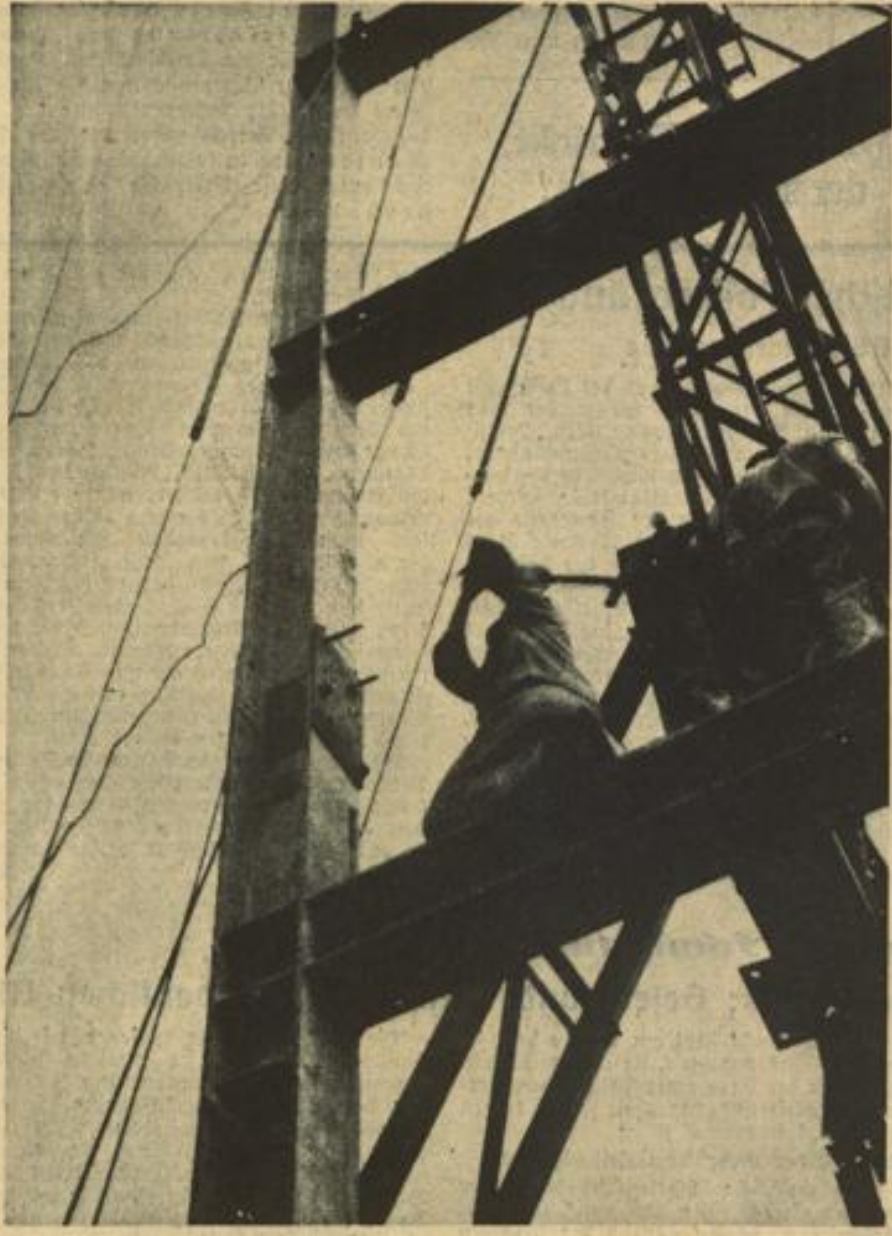
Das Haus der Deutschen Erziehung Bayern im Bau
