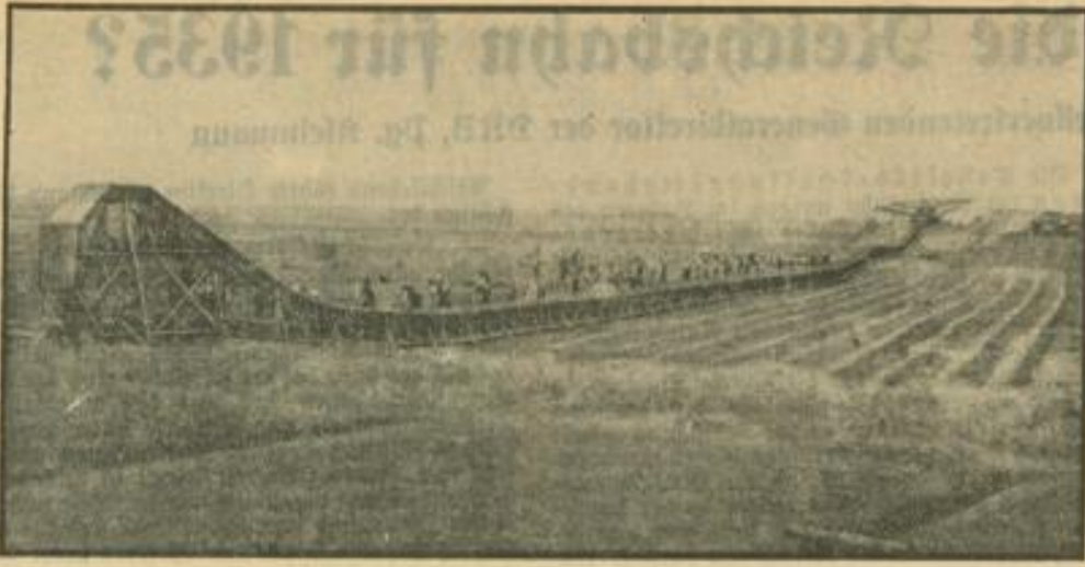
Bei den Arbeiten zur Neulanter Gewinnung an der holsteinischen Westküste werden erstmalig große Förderbänder zum Reichbau verwendet. Der aus dem Vorland entnommene Boden wird auf den Plattensörderer geschaukelt und an der Verwendungsstelle durch Verteiler nach beiden Seiten abgeworfen. Die Bänder besitzen eine Förderlänge von 300 Meter, ihre Stundenleistung beträgt 150 Kubikmeter.
