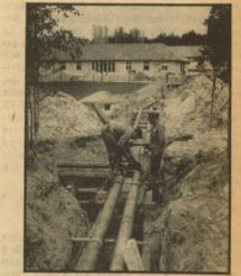
Das Olympische Dorf wächst. Die Fernheizröhren für das Olympische Dorf. Jedes Haus erhält eine Heizung. (HB-Bildstock)
