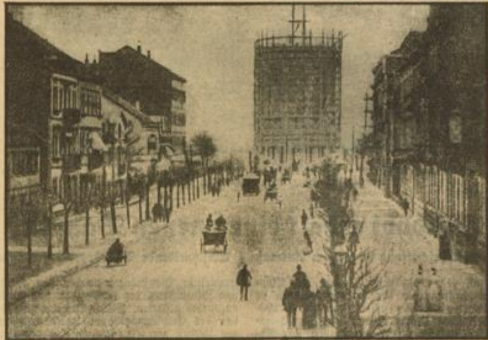
Anno 1884: Der Wasserturm im Bau. Eine Aufnahme aus dem gemütlichen Alt-Mannheim. — Im Vordergrund das hohe Rundgerüst. Aufnahme aus Privatbesitz. HB-Bildstock
