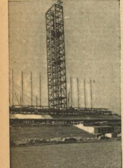
Der Führturm auf dem Reichssportfeld im gegenwärtigen Bauzustand. Der 76 Meter hohe Bau wächst aus einer Ehrenhalle heraus, in der am Eröffnungstage 22 Spiele der Präsident des Internationalen Olympischen Komitees und der des Organisationskomitees für die XI. Olympiade den Führer und Kanzler empfangen und ihm ihre Rollen vorstellen werden, um ihn dann zur Eröffnungsfest in Stadion Olympia-Pressbild zu geleiten.
