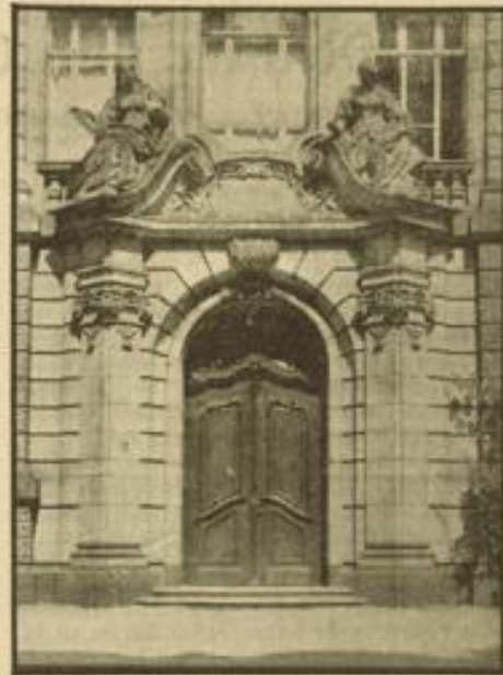
„Nicht für die Schule, sondern für das Leben“ — steht über diesem Schuleingang zu lesen.
