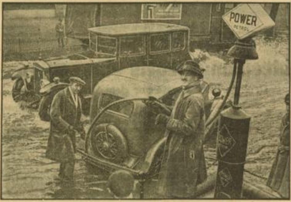
Die Tankstelle im Wasser. Eine Aufnahme aus dem Uberschwemmungsgebiet der Themse bei Maldenhead. Hier hat das Hochwasser eine Höhe von über einem Meter erreicht.
