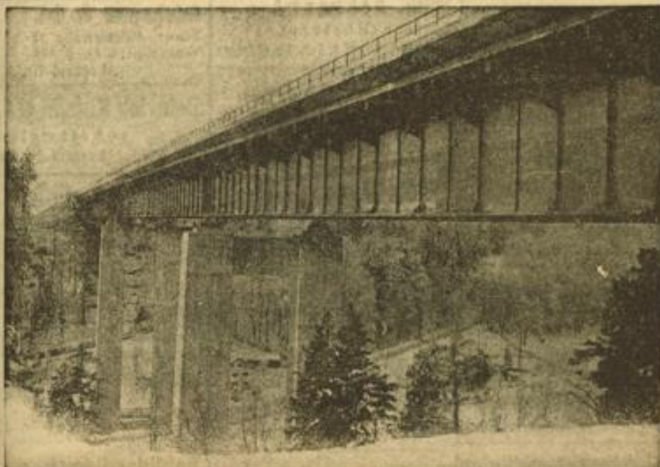
Die Mangfallbrücke im Zuge der Reichsautobahn München—Landesgrenze, die sich ausgezeichnet in das Bild der Landschaft einfügt.
