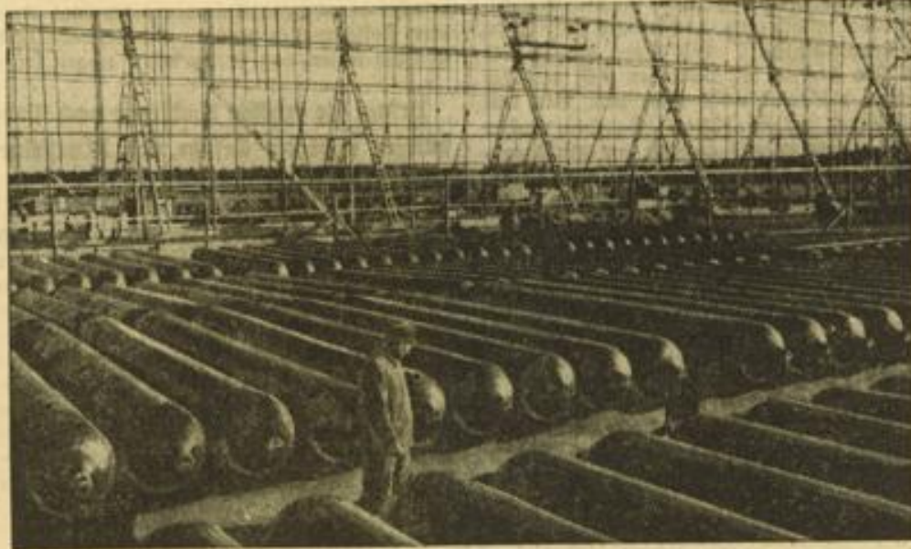
Weltflughafen Rhein-Main im Werden. Weitbild (M) Neben der im Gerät nahezu vollendeten riesigen Zeppelinhalle des Luftschiffhafens Rhein-Main bei Frankfurt lagern Gasbehälter.
