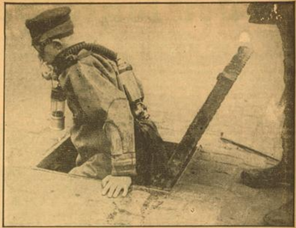
Auf dem Weg in die Tiefe. Mit Gummianzug, Sauerstoffapparat, Sicherheitslampe und Schutzhülle ausgerüstet erfolgt der Einstieg in die keineswegs ungefährliche Tiefe der unterirdischen Kanalisationsanlagen.
