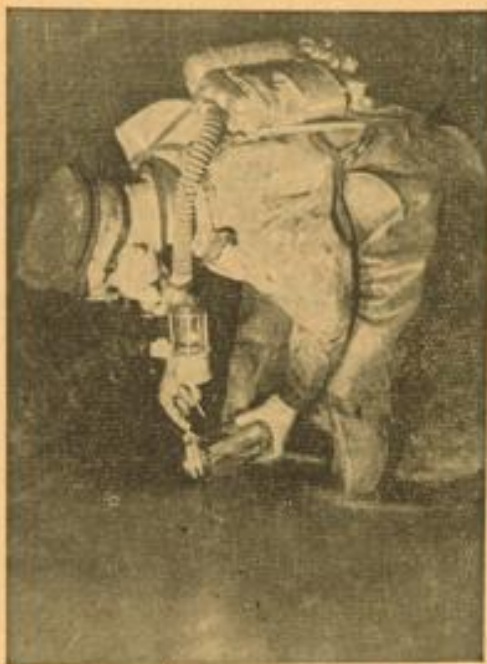
In regelmäßigen Abständen muß an den einzelnen Stellen der Kanalisations-Anlage die Zusammensetzung des Wassers geprüft werden. Unser Bild zeigt eine Wasserproben-Einnahme, die natürlich unter Anwendung aller nötigen Vorsichtsmaßnahmen erfolgt.
