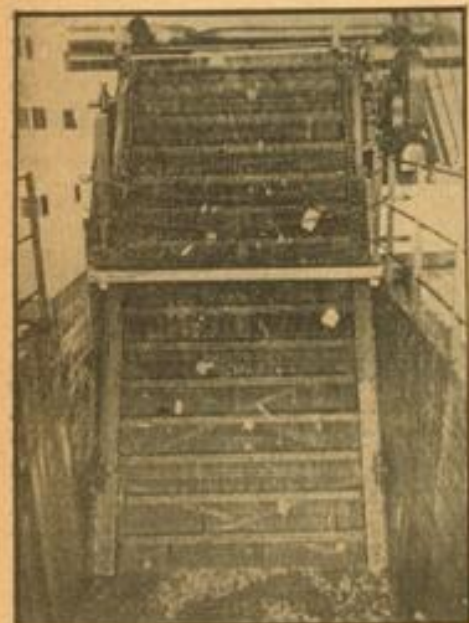
Großes Reinigungsgitter in einem unterirdischen Kanal
