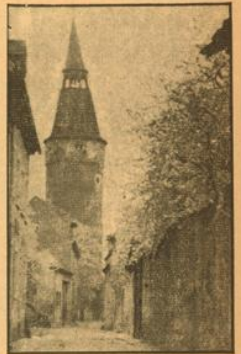
Der Fallerturm in Kitzingen am Main
