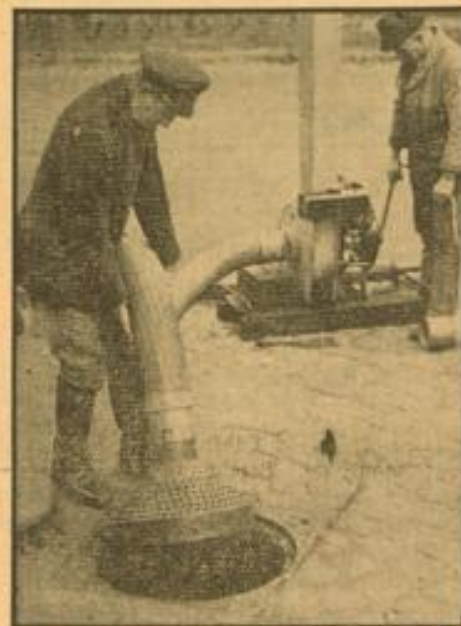
Die schädlichen Kanalgerüche müssen von Zeit zu Zeit abgesaugt werden; das geschieht mit Hilfe riesiger Saugapparate, ähnlich unseren Staubsaugern.
