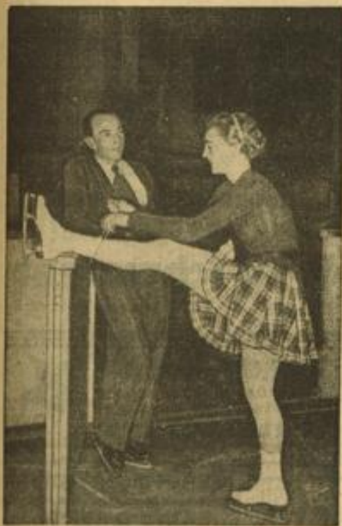
In Berliner Sportpalast ist das Training für die Europa-Meisterschaften im Eiskunstlauf, die vom 24. bis 26. Januar ausgetragen werden, bereits in vollem Gange. Unser Bild zeigt das deutsche Meisterpaar Maxie Herber und Ernst Baier während einer Pause. Weltbild (M)
