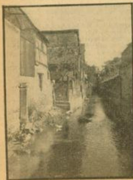
An der früheren Schwetzingen Schwemme
