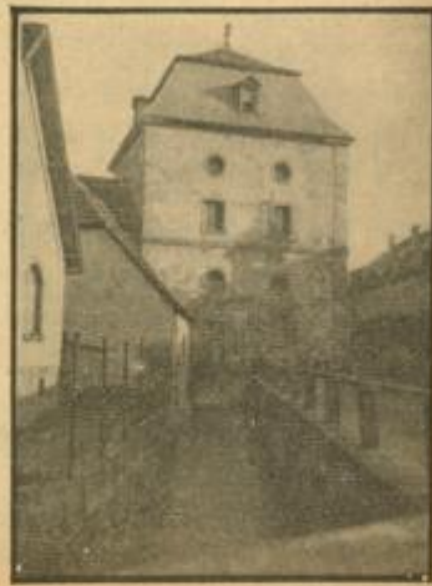
Das obere Schwetzingen Wasserwerk
