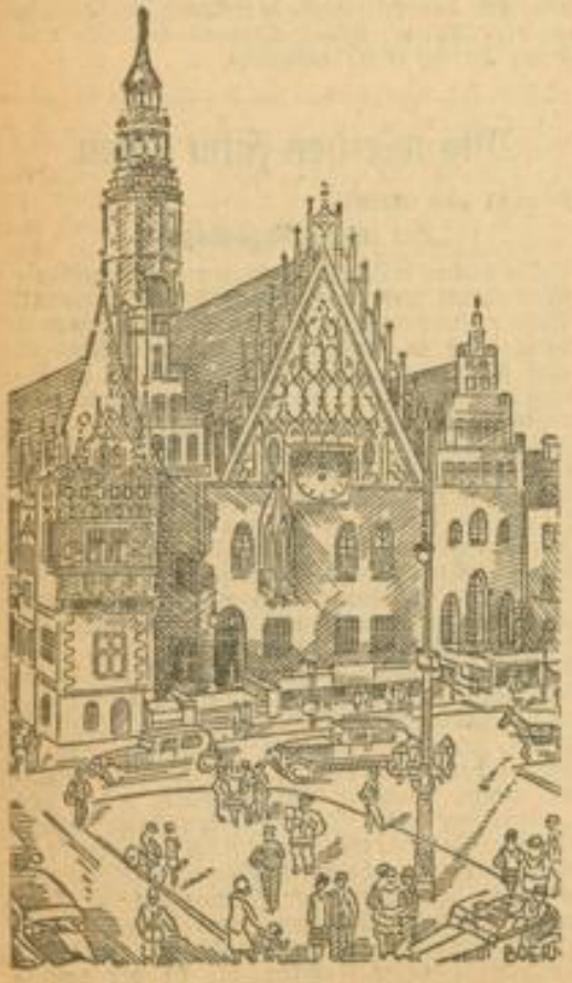
Das Rathaus in Breslau Bildarchiv der Reichsbahnzentrale
