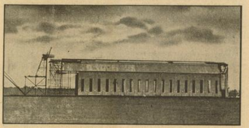
Die neue Luftschiffhalle in Frankfurt a. Main Weltbild (M) Die im Rohbau fertiggestellte neue Luftschiffhalle im Frankfurter Stadthafen. Bereits im Frühjahr soll der Weltflughafen Rhein-Main, der Sammelplatz für den transozeanischen Luftschiffverkehr, seiner Bestimmung übergeben werden.
