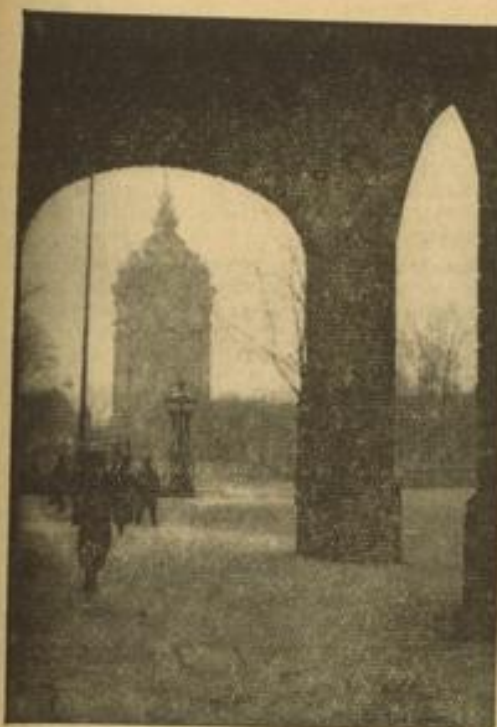
Blick durch die Arkaden auf das Wahrzeichen Mannheims, den Wasserturm
