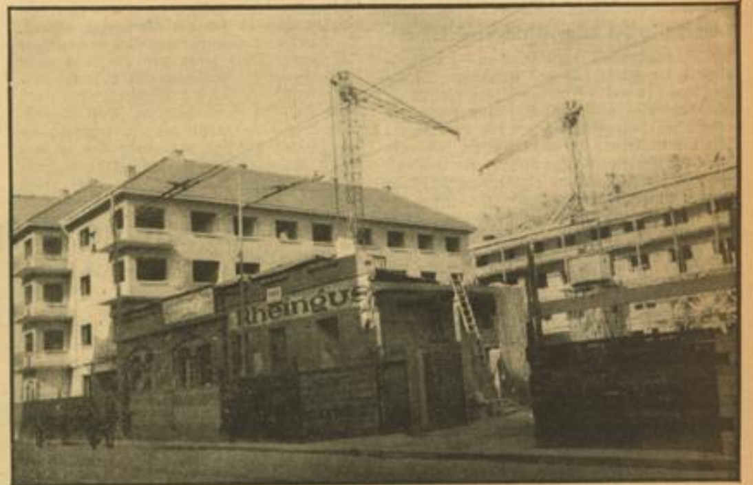
...unser Bild zeigt den Rest eines Mannheimer Fabrikgebäudes, an dessen Stelle Neubauten mit 114 sonnigen Wohnungen treten
