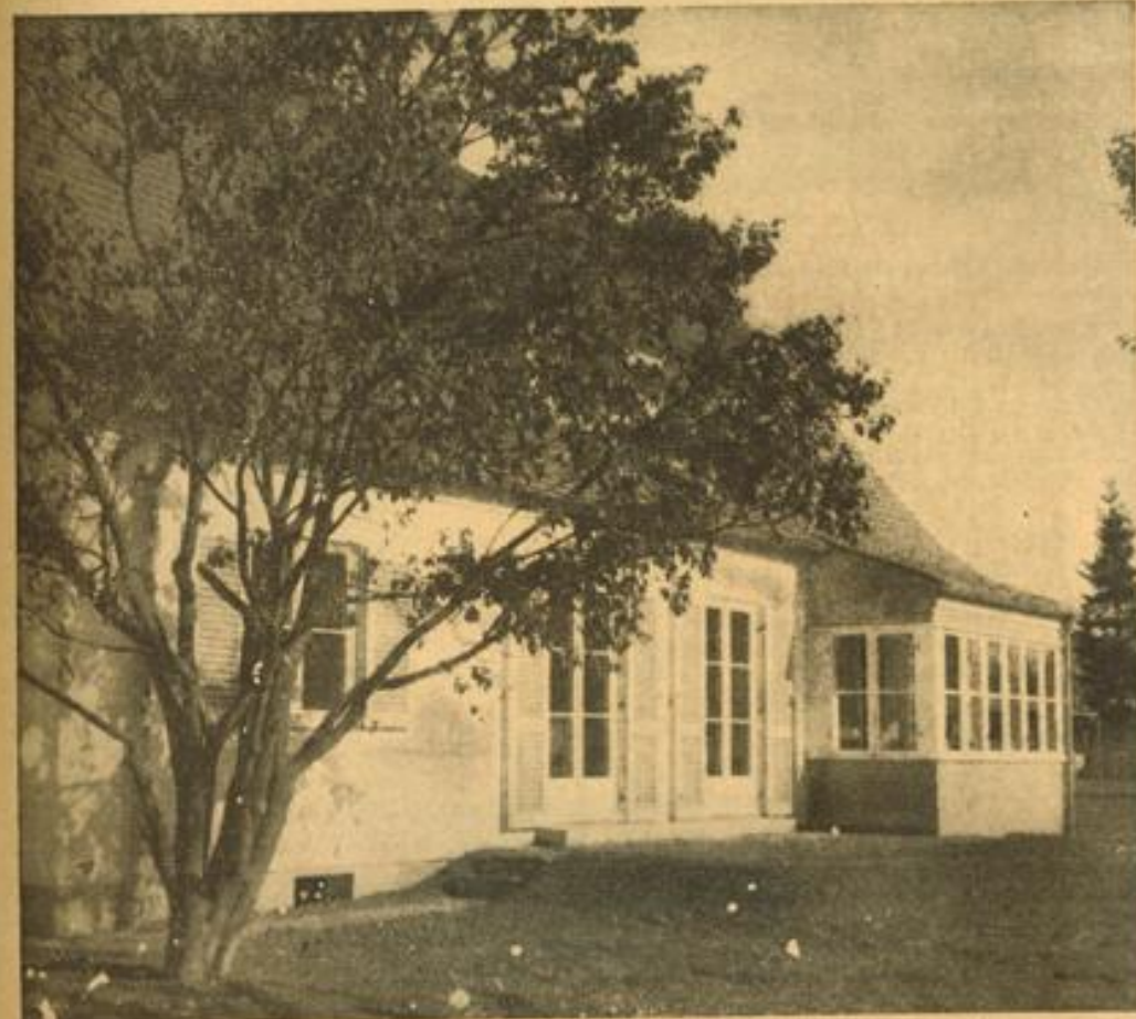
Ein Wohnhaus mit Garten. Der Fußboden in den Zimmern liegt mit dem Gartengelände fast auf einer Höhe. Freundlich öffnen sich zwei Türen nach außen. Eine Wohnzelle schiebt sich aus dem Baukörper heraus mit möglichst vielen Fenstern. Hier sitzt man unter Dach, gegen Wind geschützt, aber doch wie im Freien. Diese Hauswand bedarf keines Schmuckes, die Anordnung der Öffnungen, ihre Verhältnisse zur Hauswand machen das Haus lebendig und schön.
