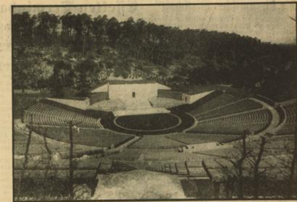
An den Olympiabauten wird mit Hochdruck gearbeitet. In drei Monaten muß alles fertig sein. Vollständig fertiggestellt ist bereits die Freilichtbühne, die landschaftlich äußerst reizvoll gelegen, einen imposanten Anblick bietet. Pressebildzentrale
