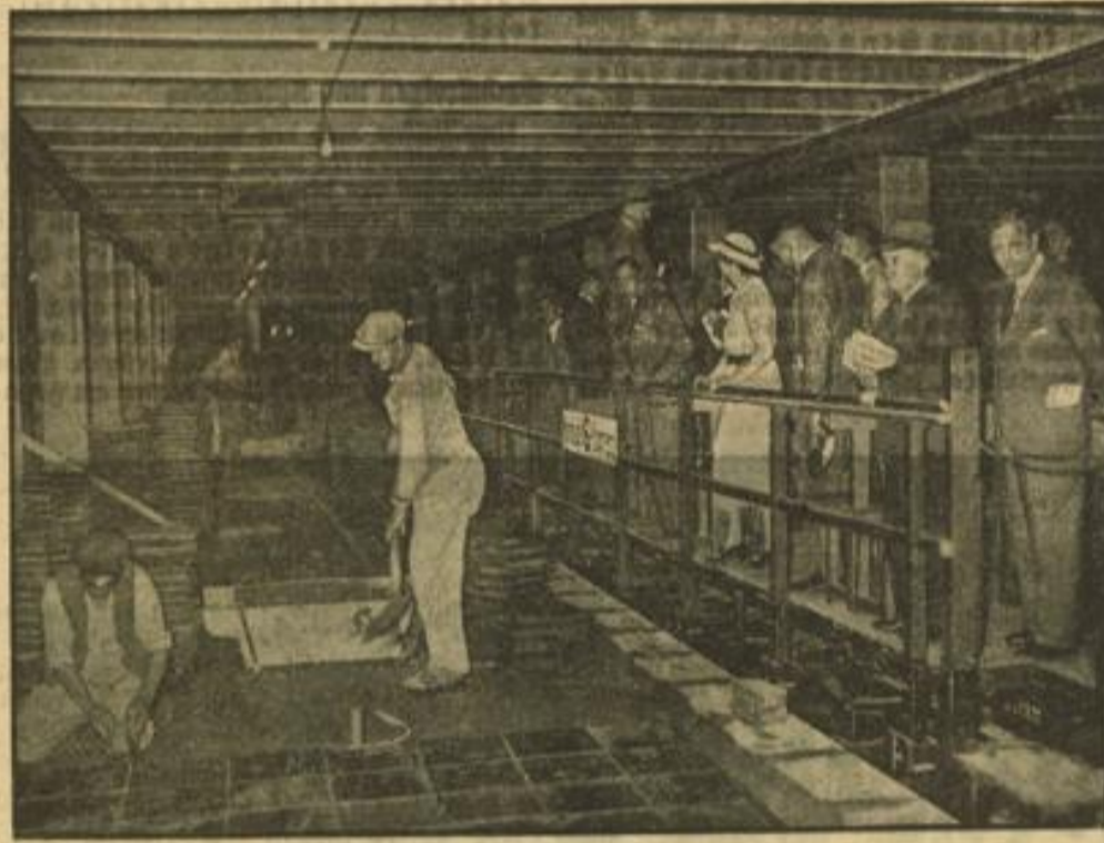
Am 28. Juli Teilstreckeneröffnung der Nord-Süd-Bahn Weisbild (M) Auf einem Arbeitswagen geht es vom Stettiner Bahnhof durch die vollständig ausgebauten Tunnelanlagen über den Bahnhofsplatz nach dem Bahnhof Friedrichstraße. — Eine Aufnahme von der ersten Besichtigungsfahrt. Noch vor Beginn der Olympischen Spiele wird dieser Streckenabschnitt dem Verkehr übergeben.
