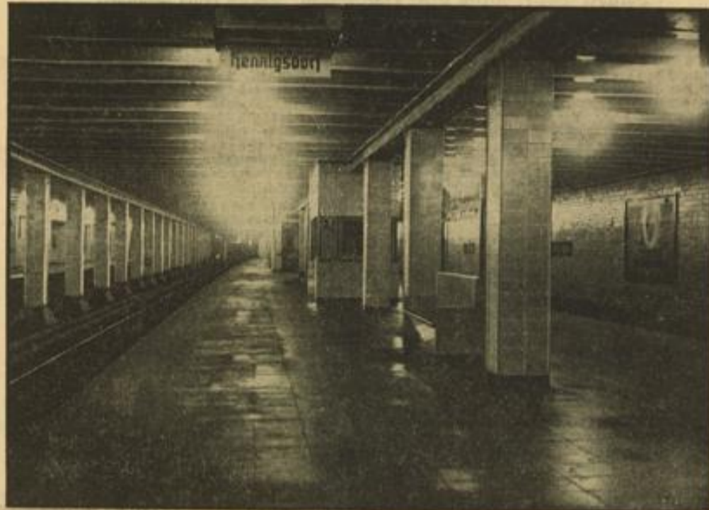
Unterirdisch vom Stettiner Bahnhof zum Brandenburger Tor. Weibild (M) Der Bahnsteig des neuen S-Bahnhofs Stettiner Bahnhof, von dem aus man nach der sechsten erfolgten Eröffnung des Nordabschnittes der Nord-Süd-S-Bahn in fünf Minuten zum Brandenburger Tor kommt.
