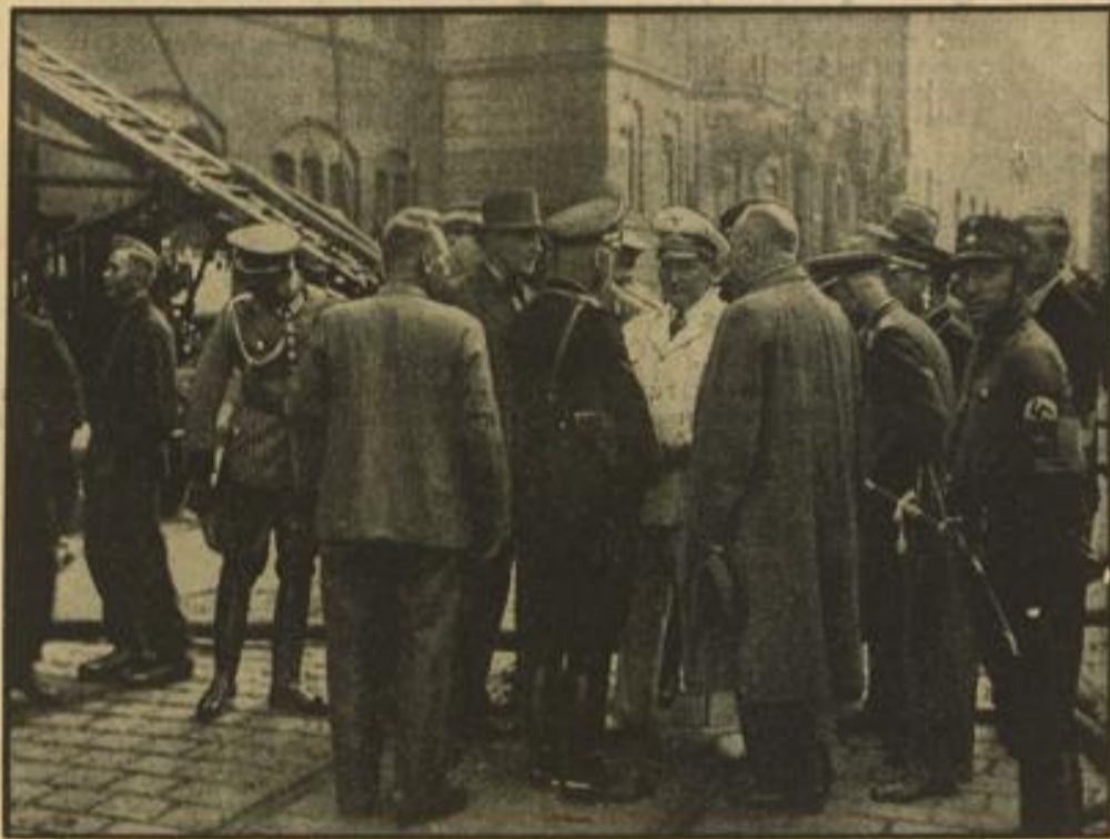
Feuerschaden im Kullissenhaus der Staatstheater. An der Brandstätte in der Prinz-Friedrich-Karl-Straße in Berlin, wo das erste und zweite Stockwerk des Kullissenhauses der preussischen Staatstheater durch Feuer heimgesucht wurde. — Unser Bild zeigt: Generaloberst Göring, Staatssekretär Pfandner, Reichsführer SS Himmler, Staatssekretär Körner und Polizeipräsident Graf Heißdorf.
