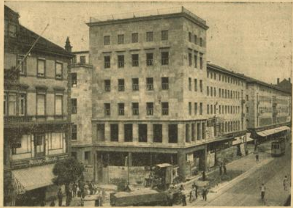
Das letzte Plankstück wird asphaltiert Kurz vor der Freigabe der letzten Etappe des Plankendurchbruchs
