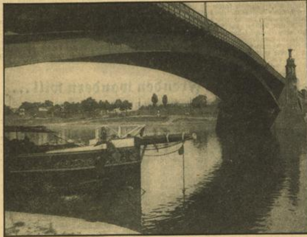
Unter der Hindenburgbrücke
