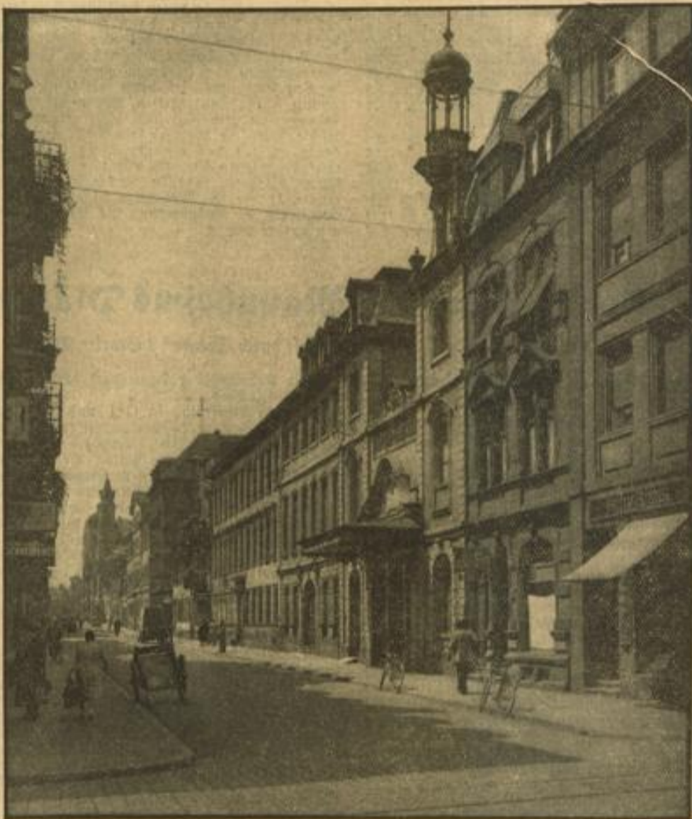
Archivbild Eine Aufnahme vor der Niederlegung des alten Apollo-Theaters, an dessen Stelle sich jetzt die Mauern der neuen Wohnhäuser emporrecken. Durch diese Maßnahme wird sich das Gesicht dieser Straße sehr zum Vorteil verändern.
