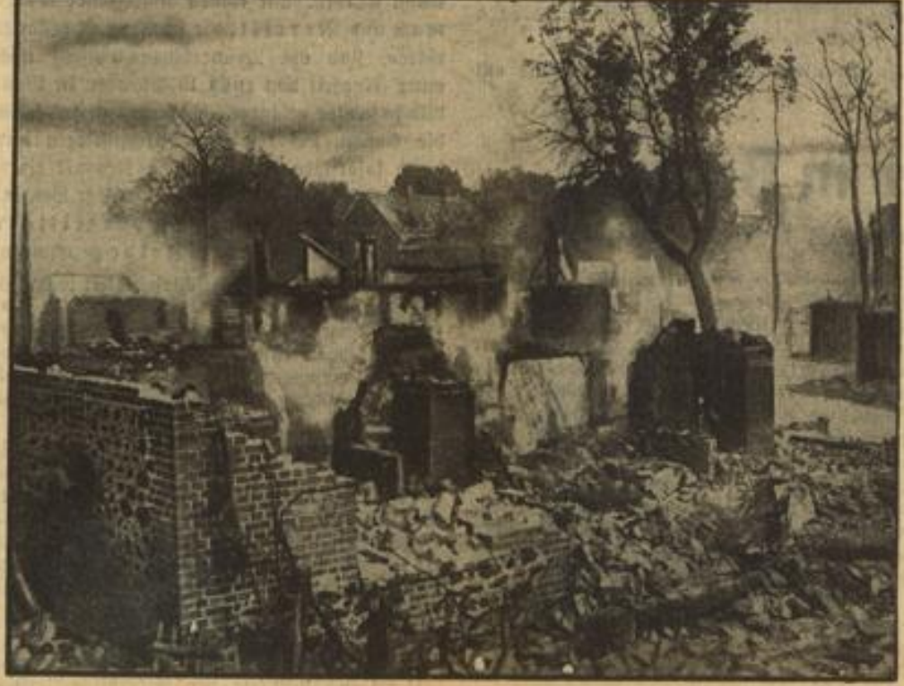
Das von einem Riesebbrand heimgesucht und völlig eingedörrte Dorf Warlow bei Ludwigsfelde. Zusammen mit den Gehöften wurde die gerade eingebaute Ernte v. nicht, so daß sich der Schaden auf über 300 000 Mk. beläuft. Der Reichsanstalt hat sich sofort der obdachlos gewordenen Basern angenommen. Weisbild (10)
