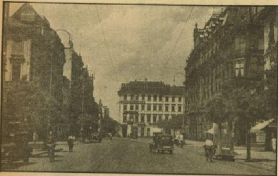
Der Stein des Anstoßes von „gegenüber“ mußte ebenfalls verschwinden Der bereits abgebrochene erste Häuserblock der E-Planken Archivbild
