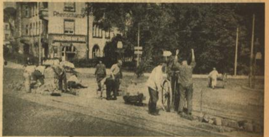
Au der Rheinlust wurden in den letzten Wochen umfangreiche Arbeiten an den Straßenbahngleisen vorgenommen, um die Sicherheit im Straßenbahnbetrieb zu gewährleisten. (Ausz.: Jütte)
