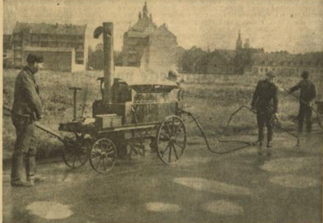
Zahlreiche Kolonnen sind gegenwärtig unterwegs, um die schadhaften Stellen der getoerten Straßen auszubessern und unsere Straßen in einen ordentlichen Zustand zu versetzen. (Anst. Jette)
