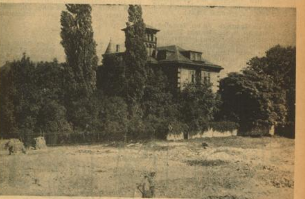
Die Aufschüttungsarbeiten am Adolf-Hitler-Ufer gehen ununterbrochen weiter. Immer näher rücken die Schutthalde der einsam stehenden Villa Hartmann, die ebenfalls niedergelagt und im Frühjahr verschwinden wird. Aufn.: Jütte
