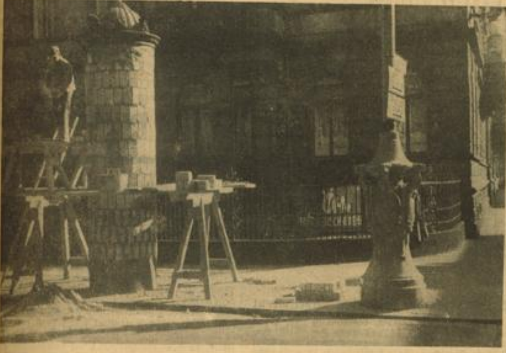
Mit Backsteinen wurde der Umfang von 65 Mannheimer Plakatsäulen erweitert, um die Anschlagtafeln auf den vorgeschriebenen Umfang zu bringen. Aufn.: Jütte
